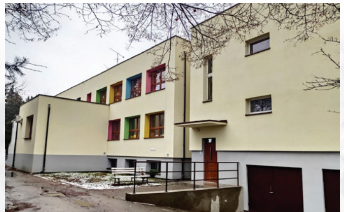
Budynek przedszkola po termomodernizacji
