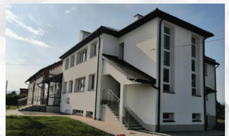
Termomodernizacja przedszkola w Janowicach
